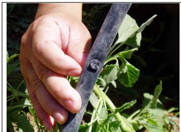
5. 在散水支管安装的喷嘴 (新疆维吾尔自治区瓜果葡萄研究中心)
