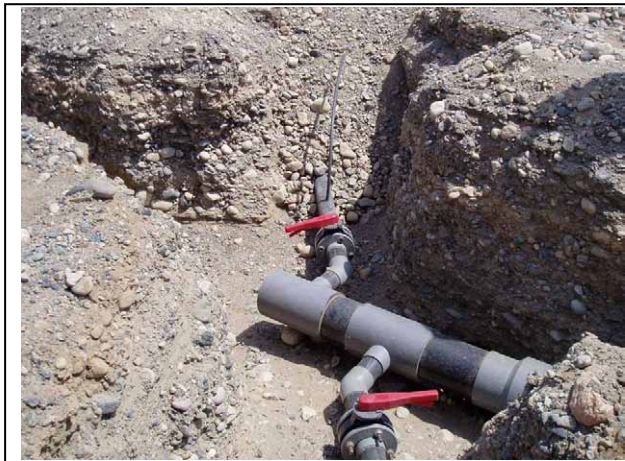
9. 埋设于地下的滴灌用配管 (托克逊县依拉湖乡红枣滴灌项目)
