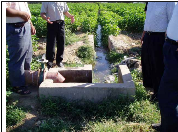
11. 低压管道灌供水的情形 (鄯善县达浪乡坎英坎儿孜村)
