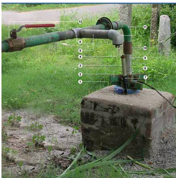
照片 10.9.7 既存井戸水位・水量測定位置
