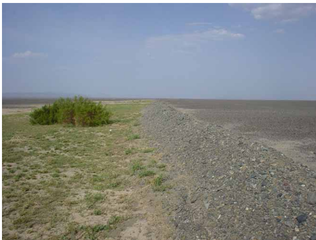
照片 10.9.1 地下水补给堰堤（托克逊县）
