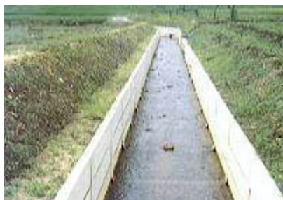
照片 10.9.6 混凝土柵渠
