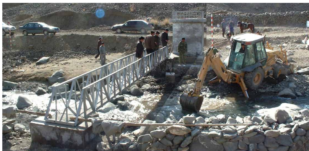
照片 3.3.2 新设水文观测站的建设现场
