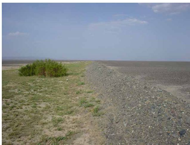
写真 10.9.1 地下水かん養堰堤(トクソン県)
