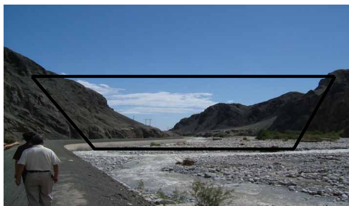
写真 10.9.2 阿拉溝ダム建設予定地(案1)
