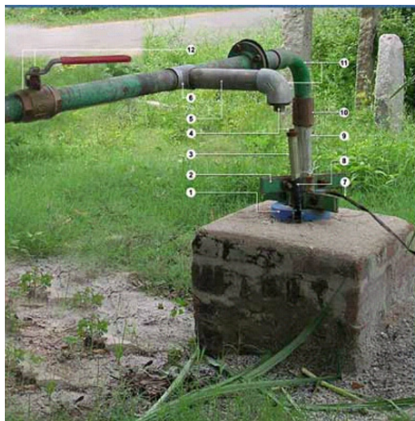
写真 10.9.7 既存井戸の水位・水量測定位置
