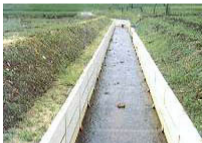
写真 10.9.6 コンクリート柵渠
