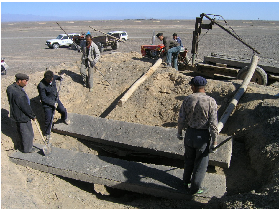
写真 5.3.4 カナートの維持管理(浚渫)作業現場
