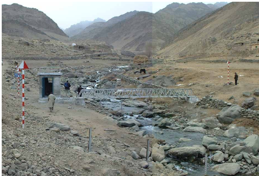
写真 3.3.3 新規水文観測所の建設完了時の様子
