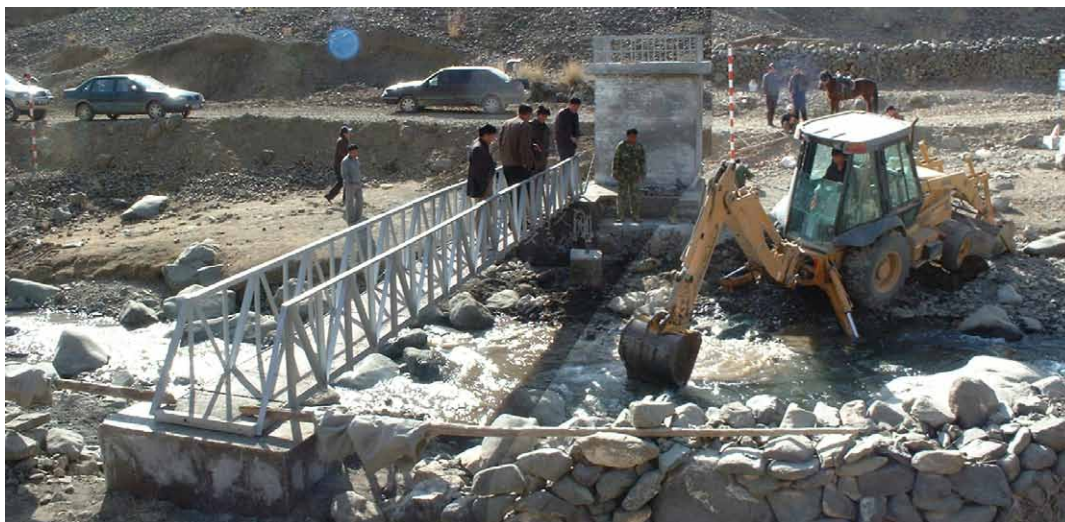
写真 3.3.2 新規水文観測所の建設現場
