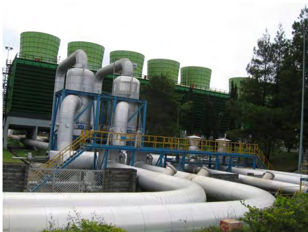
発電所冷却塔およびセパレーター（手前の塀が発電会社との境界）
