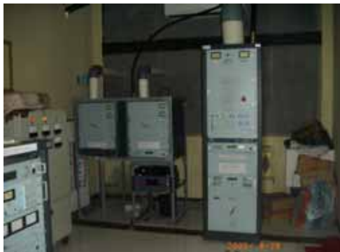
(3kW) (1kW) (10kW : 地方政府所有物) RRI タラカン FM 送信機
