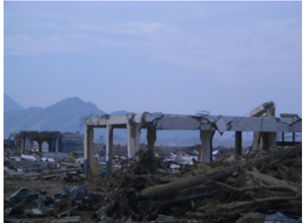
崩壊した建物
