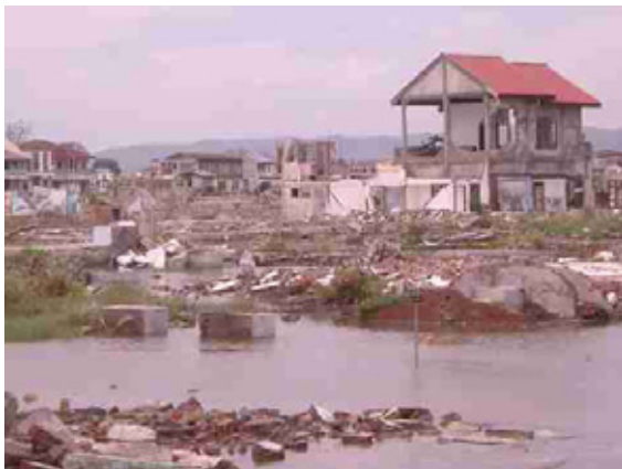
沿海地区の浸水状況
