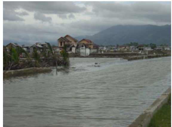
崩壊した堤防 (ドイ川)
