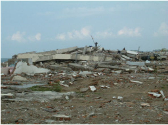
崩壊した建物
