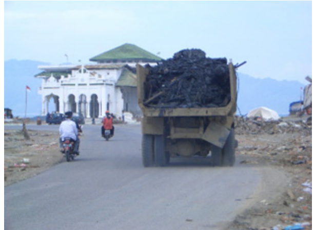
瓦礫の撤去作業
