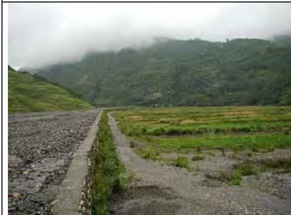
桃家小河 3 下游部分的河滩地。建起部分堤坝，开垦了农田。
