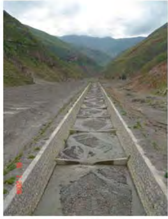
3 达朵沟排导槽
