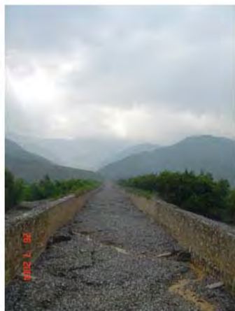
24 老干沟排导槽
