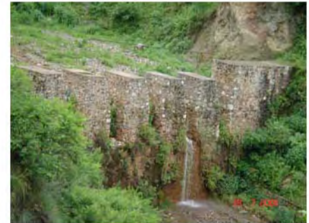
3 小水沟2号拦沙坝
