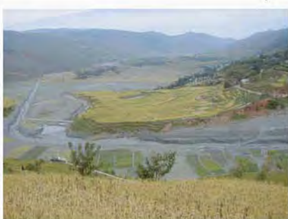
2 沙湾大沟排导槽
