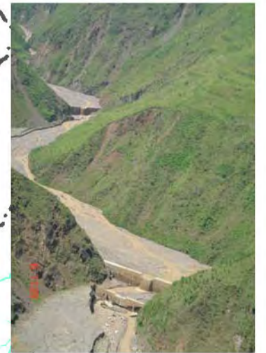
64 吊夏河1号、2号拦沙坝
