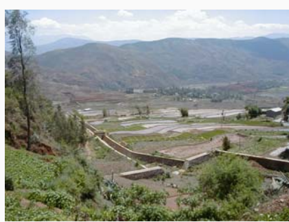
14 老龙管-野鸭塘流路工
