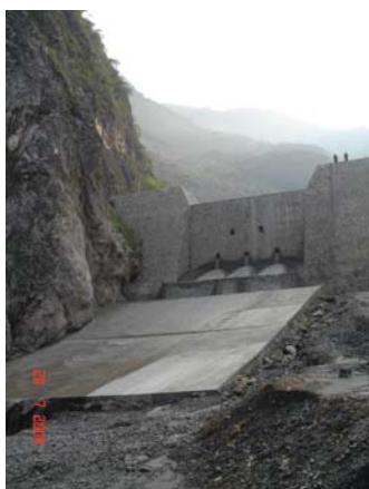
66 沙湾大沟主えん堤
