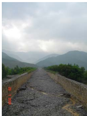
24 老干沟流路工
