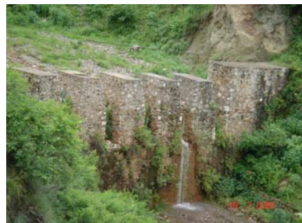
3 小水沟2号えん堤
