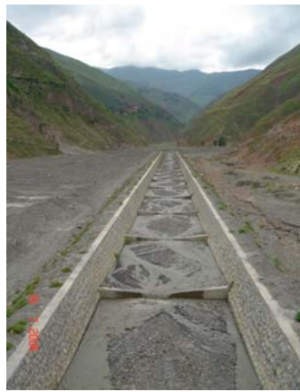
3 达朵沟流路工
