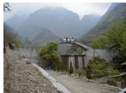
17 深沟1号えん堤
