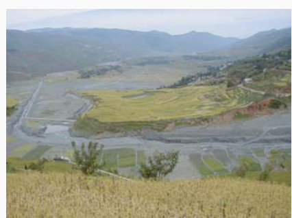
2 沙湾大沟導流堤
