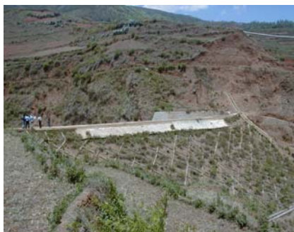
31 老龙管主えん堤
