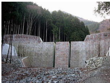
コンクリートスリット砂防えん堤
