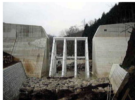
鋼製スリット砂防えん堤
