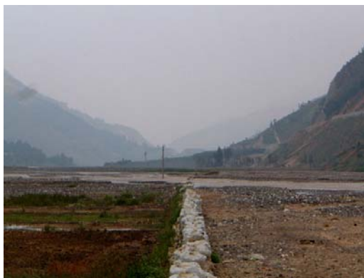
写真 埋没した石積み堤と流路の変化
