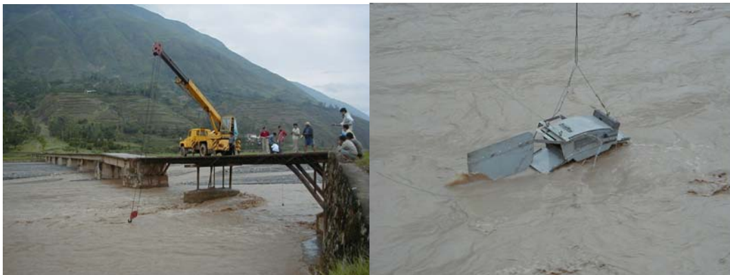
写真 中国現地で製作した掃流砂採取器と掃流砂採取状況
