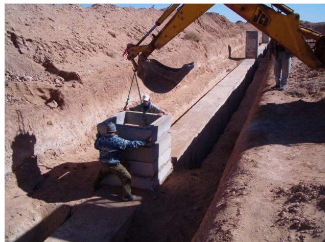
Béton préfabriqué utilisé por la khattara Oustania
