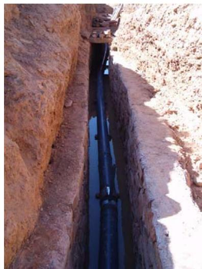
Après réhabilitation avec des parois en maçonnerie, pose d'une conduite PVC pour empêcher les fuites.
