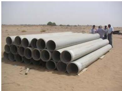
Conduite PVC (diamètre 400mm) pour atténuer les pertes au réseau dans les fondations de gravier.
