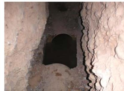
Des ouvertures sont prévues pour retirer les sédiments dans les conduites.
