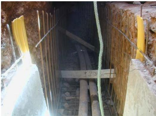
La maçonnerie actuelle a été remplacée par du béton pour réduire les infiltrations d'eaux usées. Des dispositifs d'étanchéité sont prévus sur les joints du canal en béton pour la même raison.
