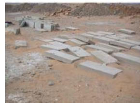
La galerie est excavée à partir du sol et recouverte de pierres plates. Sa profondeur est de 10 m environ au dessous du sol. La photo montre la galerie après le retrait des pierres de couverture afin d'assurer la sécurité à l'intérieur.
