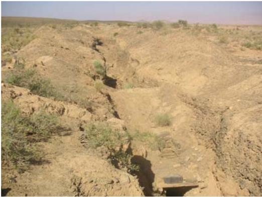
Avant réhabilitation. La paroi en maçonnerie de la galerie est endommagée par les crues.
