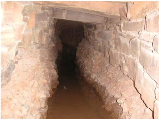
Section de galerie avant réhabilitation. Avant les travaux, les dépôts fluviaux provoquaient des fuites.
