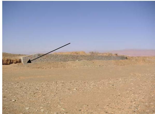
Protection contre les crues par un mur en maçonnerie (50m de long)
