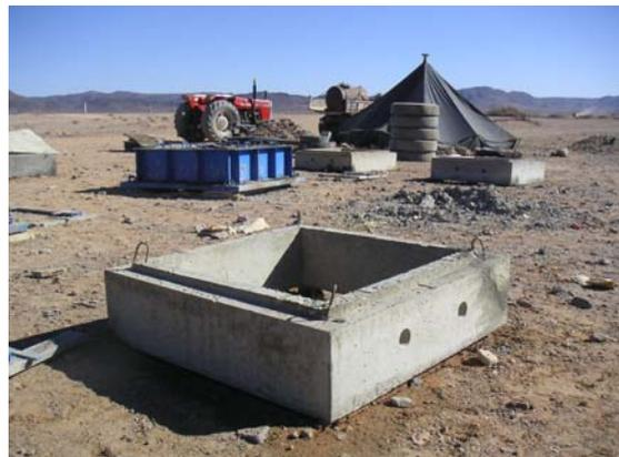
Coffrage en acier pour le béton précoulé (pour les puits)
