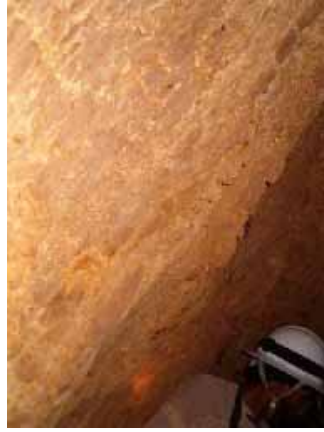
Etat à l'aval Schiste argileux altéré (stratification verticale)
