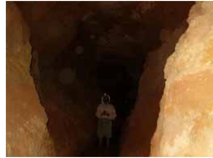
Etat du cours moyen. Parce que la lithologie autour de la khattara n'est pas constituée de lit rocheux mais de sol meuble, sa section devient plus large en raison de l'effondrement de la paroi latérale et du plafond
