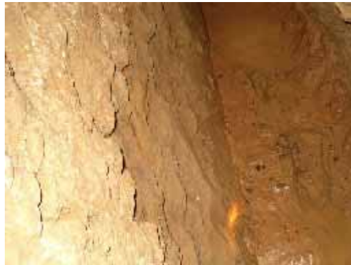
Etat autour du Puits de tête. Lit rocheux du fond et paroi latérale et couche de gravier de la portion supérieure de la paroi latérale. L'eau en très petite quantité.
