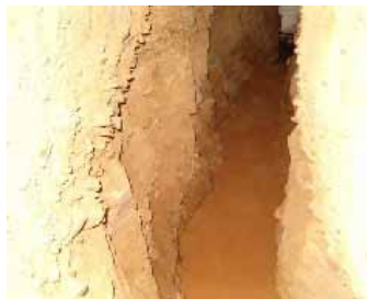
Etat à l'amont. Le fond et la paroi latérale inférieure forment le lit rocheux.
