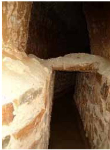
La khettara à l'aval est protégée, sa paroi latérale par la maçonnerie et les plafonds rocheux feuilletés empêchant les dépôts dans le fond de tomber du plafond
