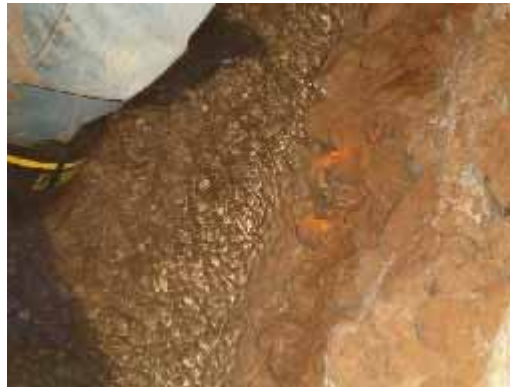
La paroi latérale est composée de sol argileux
