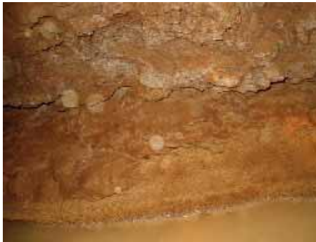
Etat de cimentation par du matériel calcaire juste en-dessus du niveau de la zone d'infiltration
