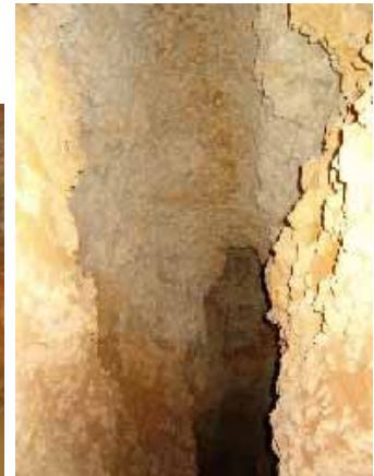
Etat de cimentation du gravier calcaireux (plafond)
