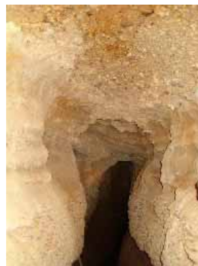
Etat de la khattara à l'amont – Couche de portion graveleuse et portion de sable horizontalement
