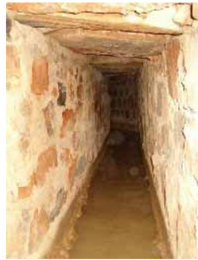
La khettara à l'aval est protégée, sa paroi latérale par la maçonnerie et les plafonds rocheux feuilletés empêchant les dépôts dans le fond de tomber du plafond
