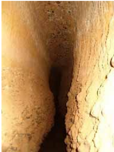
Etat des couches de gravier et de sable dans la portion à l'amont
