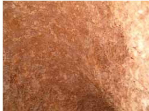
Etat du plafond dans la khattara à l'aval La couleur est foncée car les craquelures riches en argile se développent
