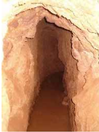
Etat à l'aval. Les conditions lithologiques autour de la khattara sont très différents du cours supérieur et moyen. Creusé complètement à travers le lit rocheux, ensuite très stable.
