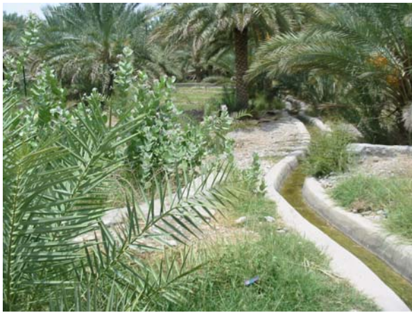
練積による1次水路
