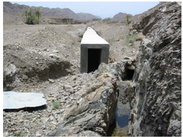
導水部の内空断面（幅 0.6m、高さ 1.2m）
