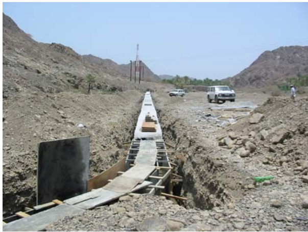
河床にある導水部の改修
