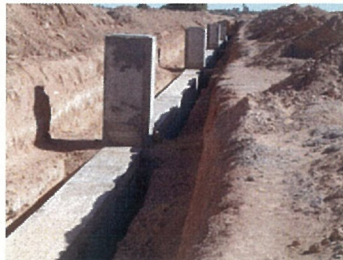
ハッターラ改修（縦坑、横坑）
