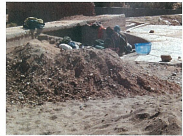
生活環境整備 (洗濯場改修)
