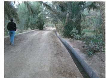
灌漑水路改修（コンクリート水路）
