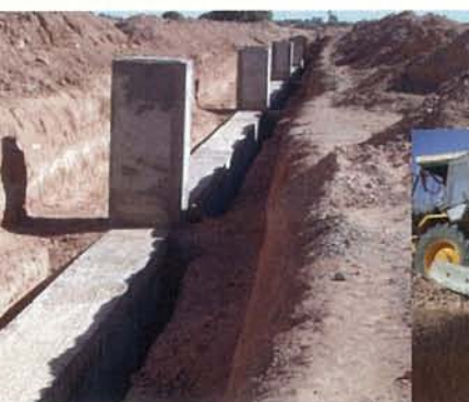
オープン掘削による改修工事
