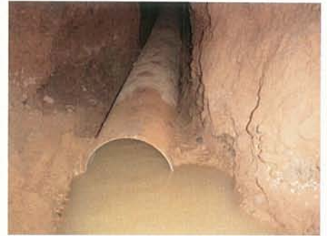
PVCパイプの敷設状況（地表下16m）
