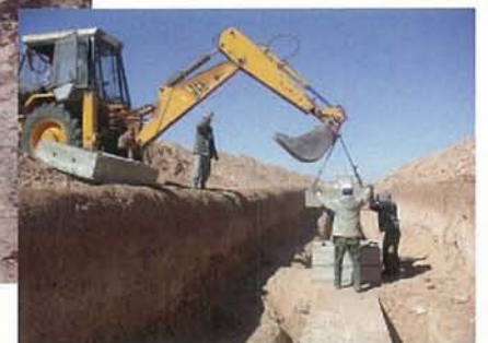
コンクリート2次製品による堅坑工事
