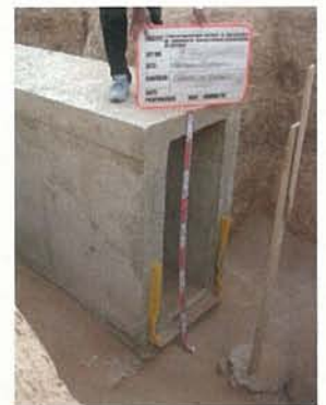
横坑の改修断面 (高さ 1.5m、幅 0.6m)
