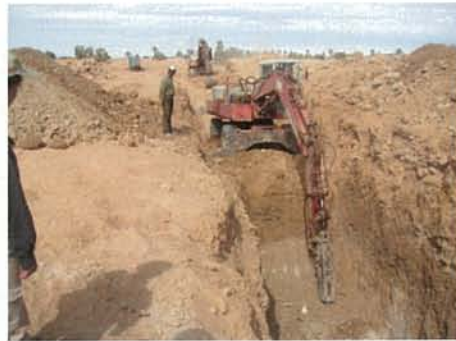
バックホー、ブレイカーによるオープン掘削工事
