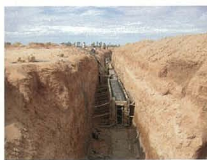
横坑のオープン掘削による 改修工事
