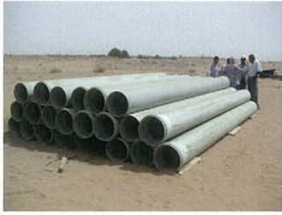
横坑の改修にPVCパイプを用い、漏水量軽減を図る。
