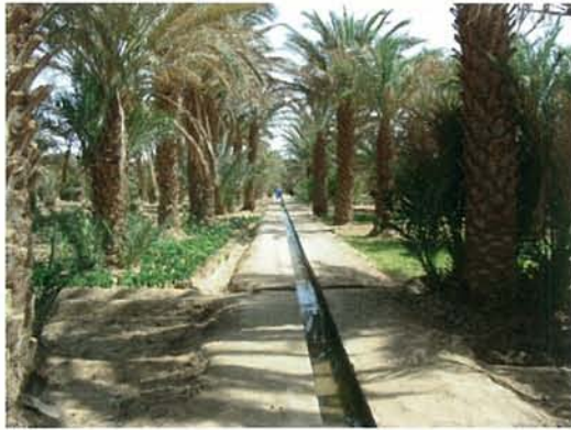
コンクリート水路による灌漑水路の改修
