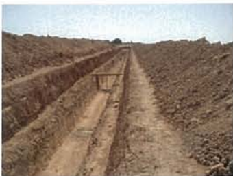
改修前の横坑の状況（坑壁は容易に崩壊する）
