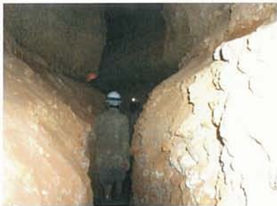
改修前の横坑の状況（坑壁は容易に崩壊する）
