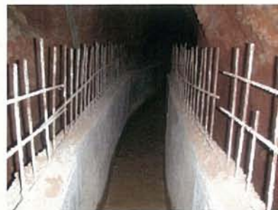
コンクリート暗渠による改修（暗渠側壁のコンクリート打設）
