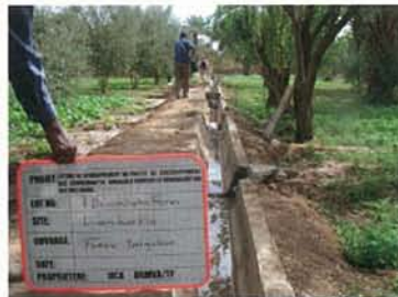
コンクリート水路による灌漑水路の改修 (灌漑損失が10%程度軽減される)
