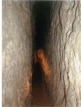
PVCパイプの敷設前
