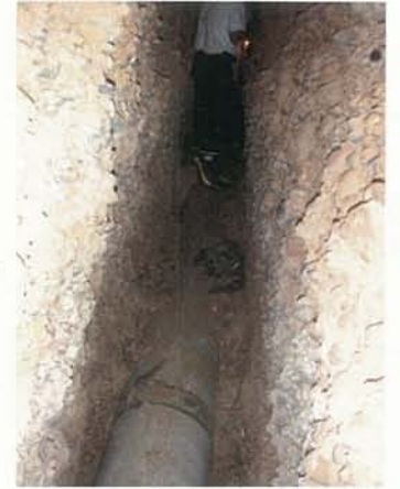
PVCパイプの敷設後
