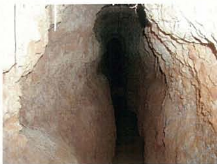
改修前のハッターラ横坑
