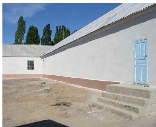
Фото 9.4 Общественный центр после ремонта
