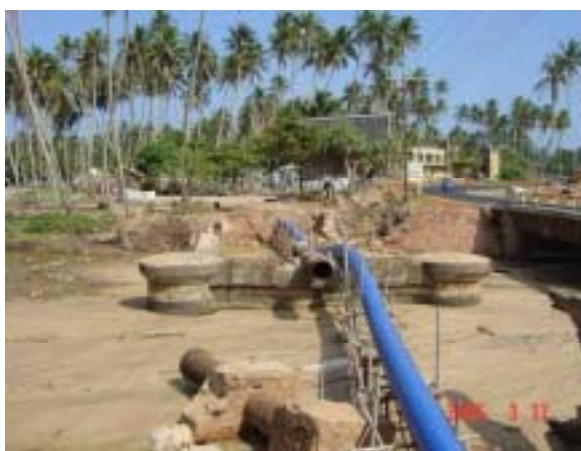
図 14 マータラ水管橋の被害状況
