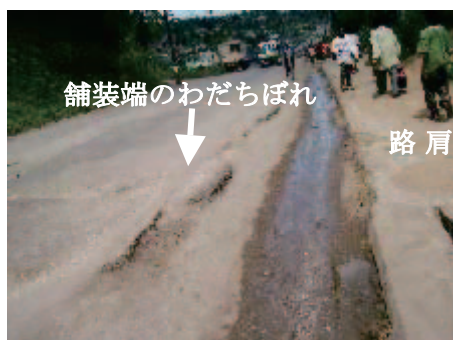
現地排水施設の現状
