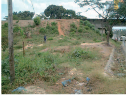
鉄道橋橋台背面盛土
