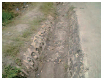
コーラル石張り排水路
