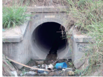
縦断排水管 φ1500mm
