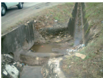
コンクリート板排水路
