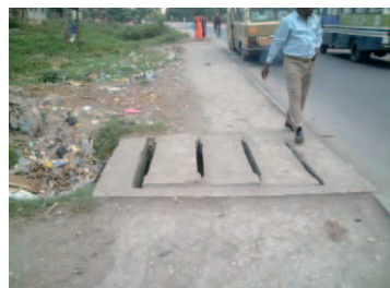
柵の現状状況
