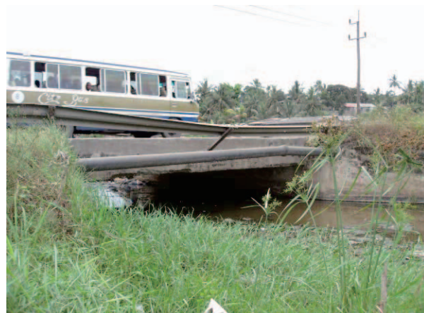
キジンガ川にかかる既存橋梁
