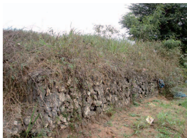
高盛土区間に設置された布団籠式擁壁
