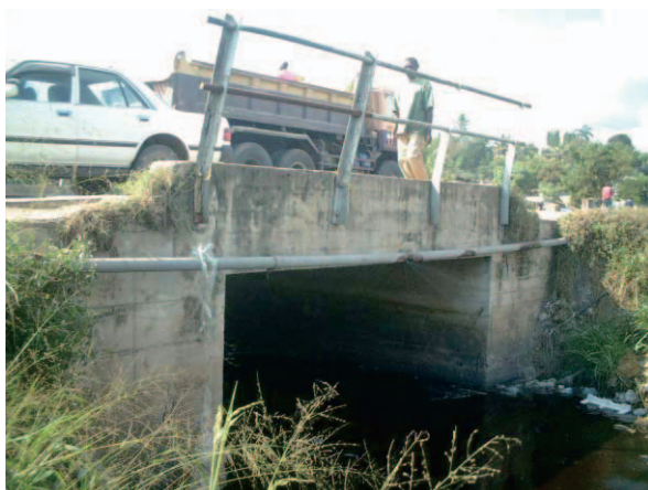
キジンガ川にかかる既存ボックスカルバート
