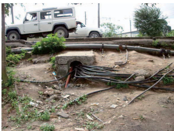
電線・水道管が組み込まれている共同溝
