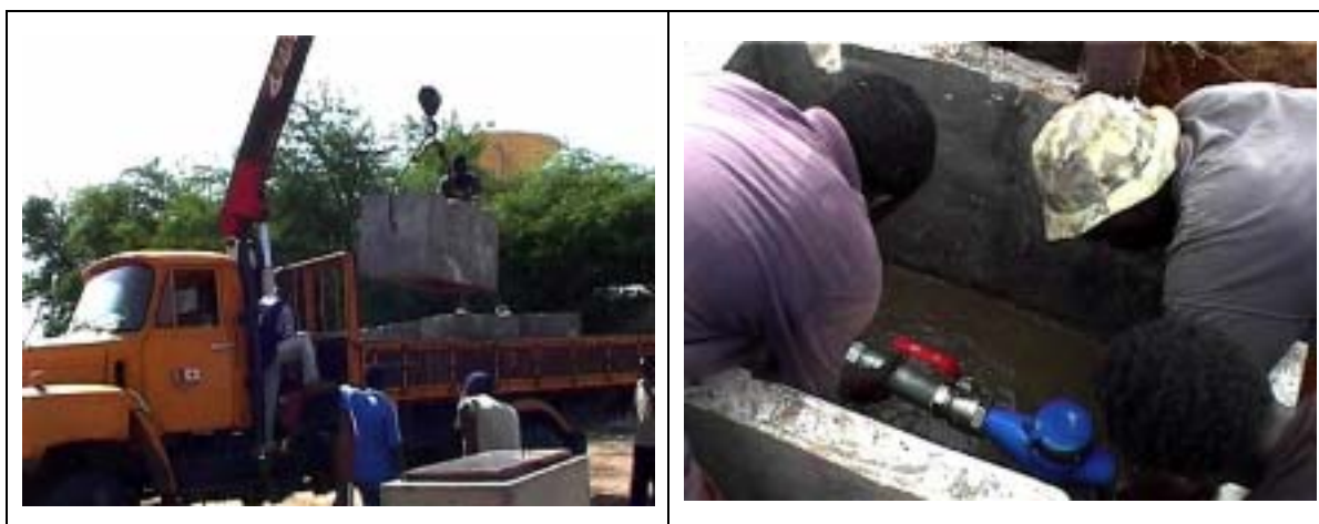
Photo Mise en place des compteurs
