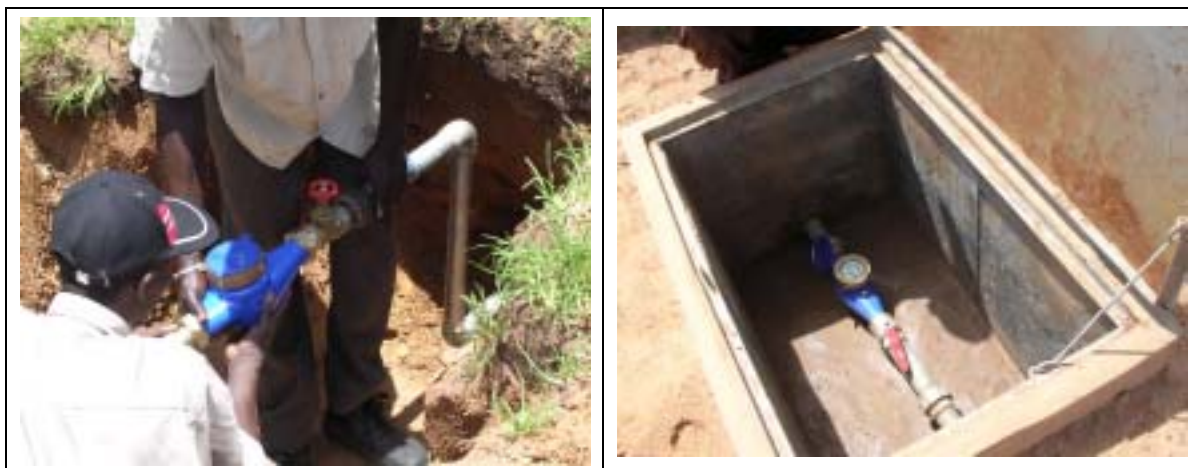
Photo Mise en place de compteur ( SINTHIU MALEME )
