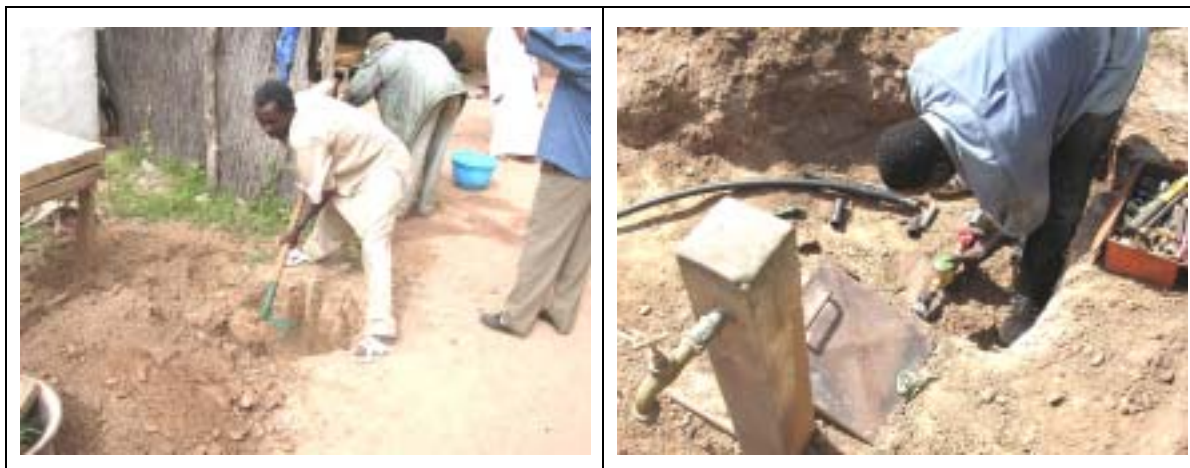
Photo Mise en place de compteur pour branchement privée
