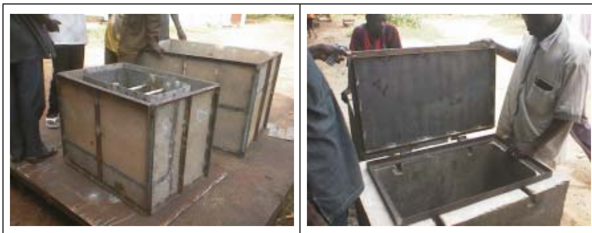
Photo Fabrication des regards des compteur à l'atelier de la Subdivision Maintenance
