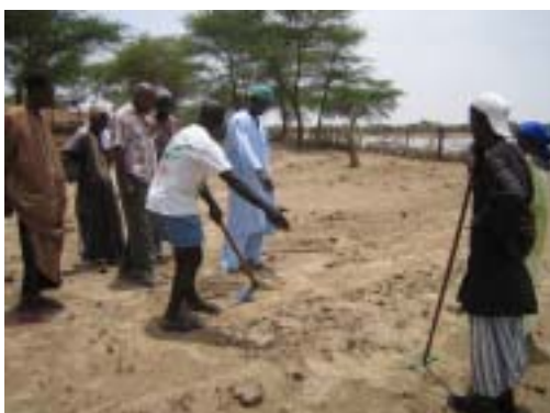
Photo Préparation d'une retenue d'eau de pluie
