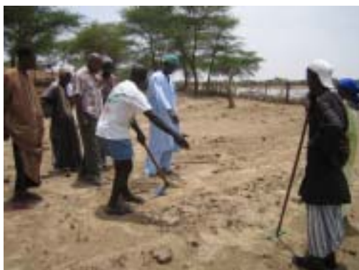
« Préparation d'une retenue d'eau de pluie »
