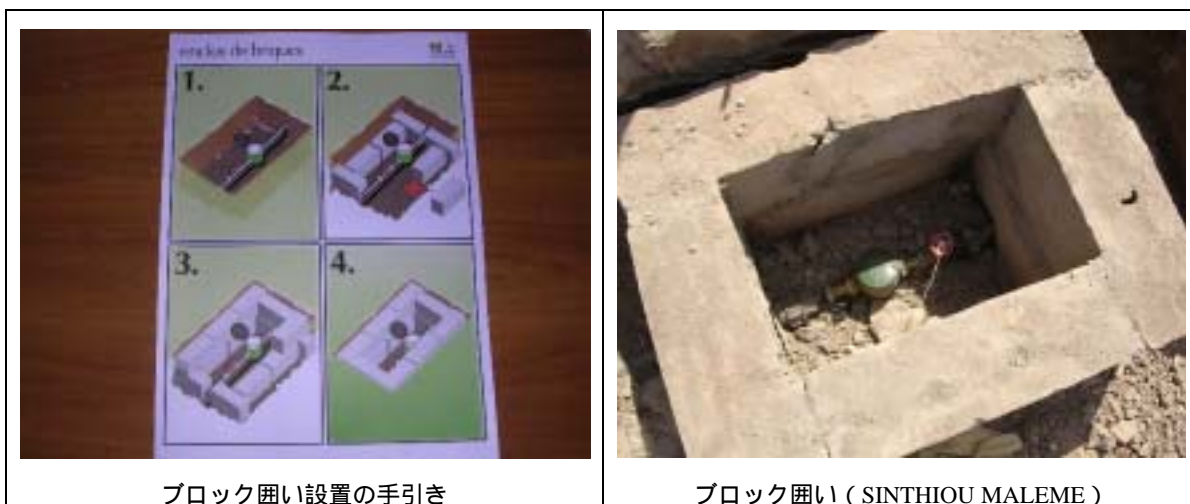
写真 7.4.5 各戸給水栓用メータのブロック囲い
