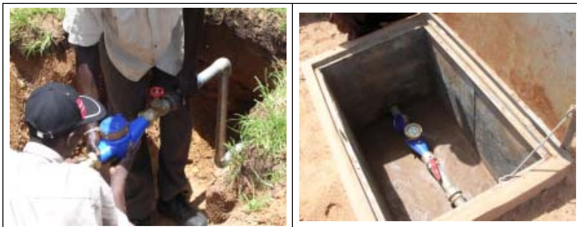
写真 7.4.4 民間業者による水道メータ設置作業 (SINTHIU MALEME)
