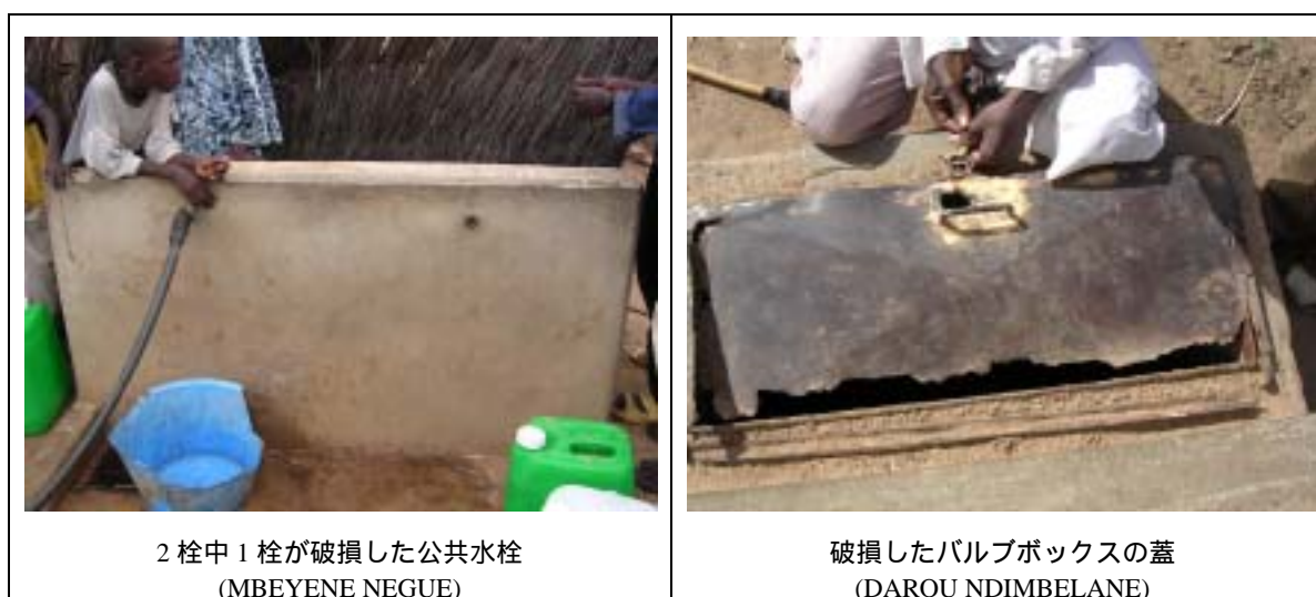
写真 7.5.3 緊急度の低い施設不具合
