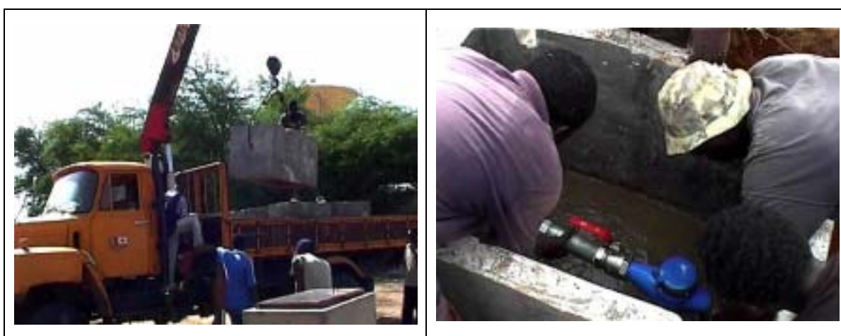
写真 7.4.3 水道メータ設置作業
