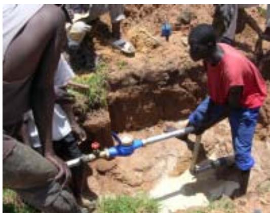
従量制移行用メーターの設置 (Diagle Sine)
