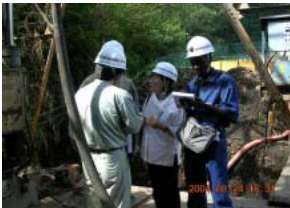
井戸掘削現場の視察
