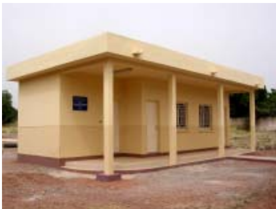
維持管理本部研修室完工 (Tambacounda : 2004 年 10 月)
