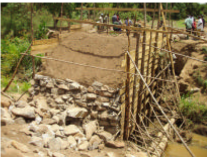
LBT によるアーチ橋の建設 2 左岸建設状況
