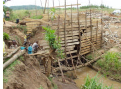
LBT によるアーチ橋の建設 1
