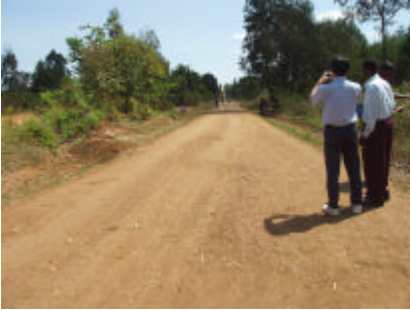
LBT 施工による路面状況
