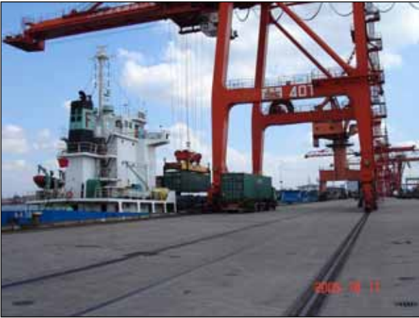
図表 Ⅲ-211 龍吳港のガントリークレーン
