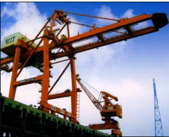
図表 Ⅲ-213 楊邏港ターミナルのクレーン2基
