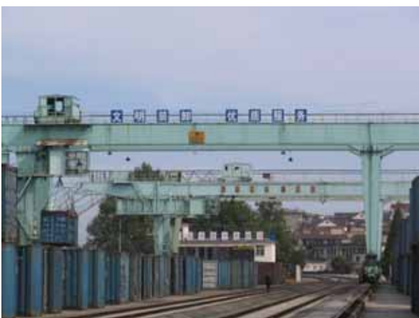
図表 III-129 コンテナヤードの門型クレーン。青く塗色
