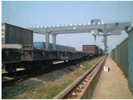
図表 - 203 岸壁側の線路を跨ぐ門型クレーン
