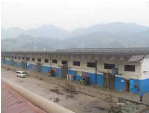
図表 III-189 混載ホーム側の倉庫建物
