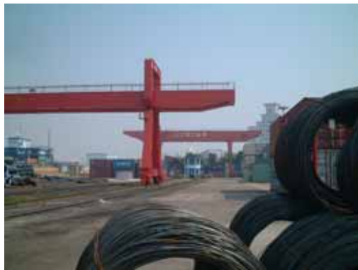
図表 - 205 岸壁の陸側に貨物引込線があり、門型クレーンが2基あった
