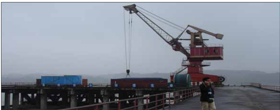
図表 Ⅲ-215 瀘州コンテナターミナルの棧橋方式のバース
