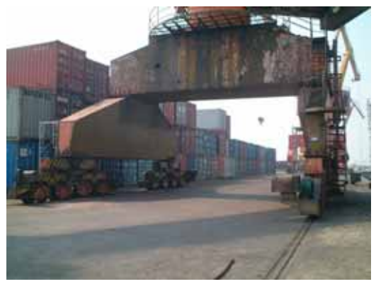
図表 - 202 上はガントリークレーン
