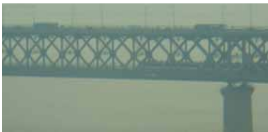
図表 - 18 武漢長江大橋 上が自動車、下が鉄道。
