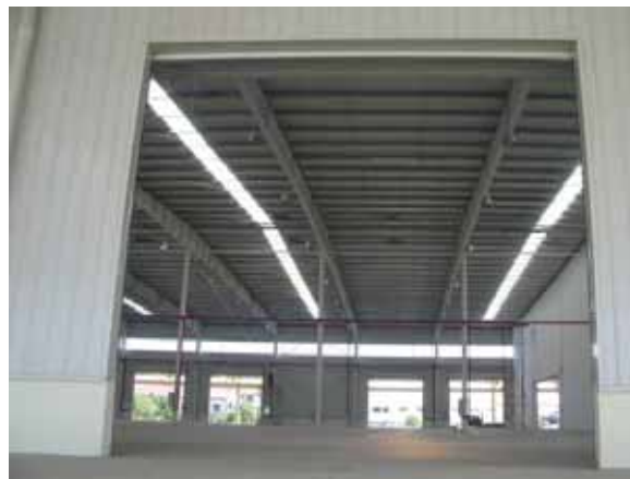
図表 - 113 倉庫シャッター
