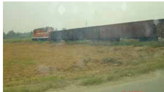
図表 - 17 開発区内の貨物引き込み線
