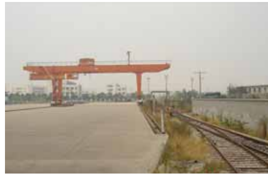
図表 - 106 鉄道引き込み線と門型クレーン 写真奥に、フランス自動車メーカー用地がある。
