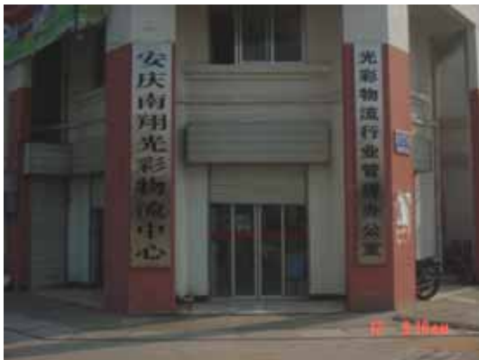
図表 - 94 物流センターの事務室
