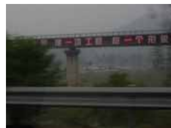
図表 - 47 建設中の鉄道
