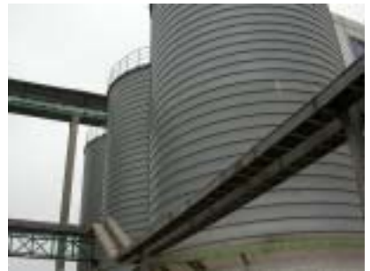
8. 圧搾前 貯蔵タンク
