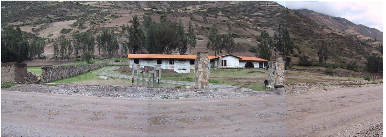
前面道路より建設予定地全景。チャビン・デ・ワントル村中心部から北約 1.3km に位置し、奥へ向って緩やかに上る地形。周囲は耕作地となっている。
