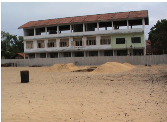
建設地(グラウンド:2005年11月)
