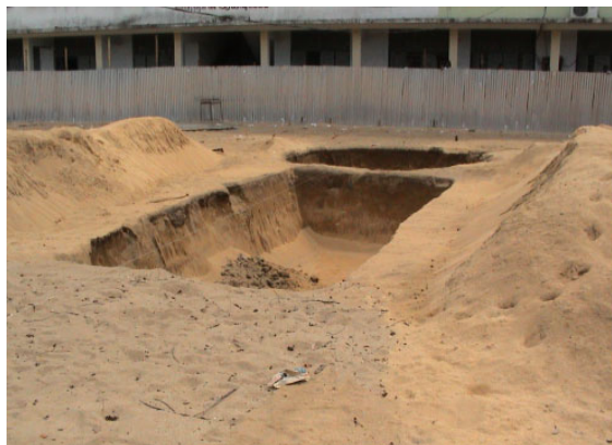
新設建物建設風景
