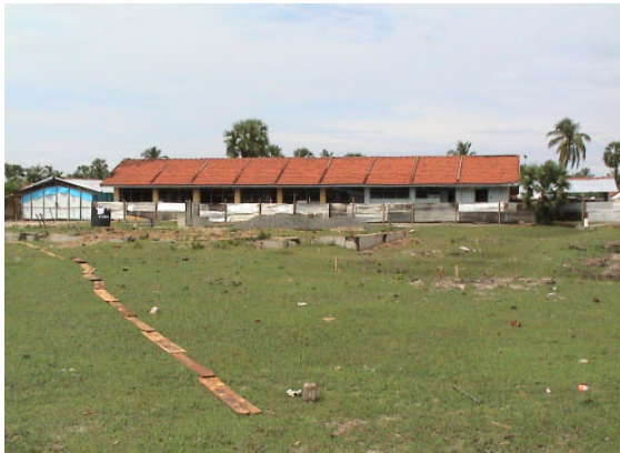
移転先(工事着手済み:2005年11月)
