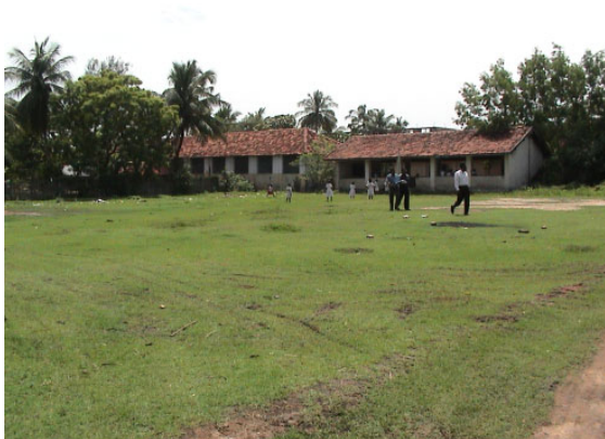
建設サイト(既存グラウンド:2005年10月)
