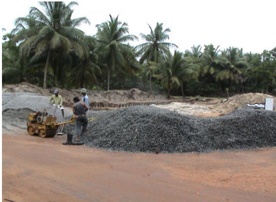
新設校舎建設風景(2005年11月)
