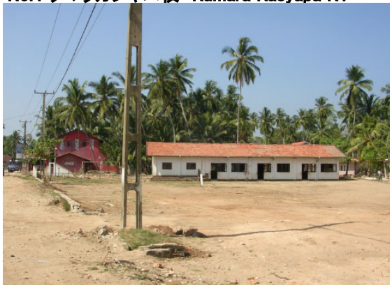
既存被災校舎(2005年2月)
