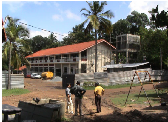
新設建物(集会室棟:2005年11月)
