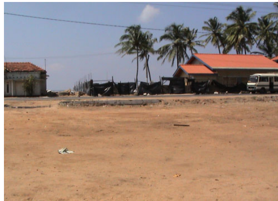
同左(瓦礫は撤去され基礎のみが残る)
