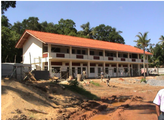
新設建物(管理棟:2005年11月)
