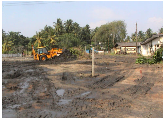
新設校舎建設風景(2005年11月)
