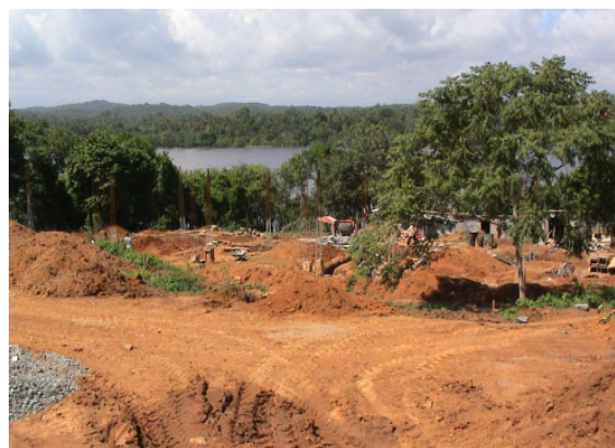
移転施設建設風景(2005年11月)
