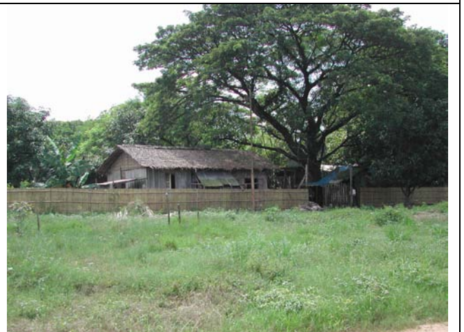
南側隣地の既存建屋
