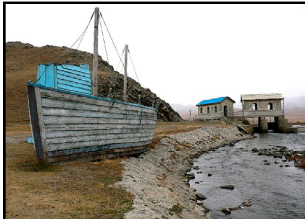
写真-8 ハラホリン取水堰
