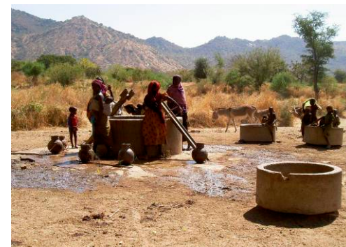
写真-16 Changuil 村の浅井戸 約 5 年前にサウジアラビアの個人が設置したコンクリート保護の浅井戸。水位 12.10m。硝酸性窒素とフッ素の濃度が飲料水基準を超える。井戸周囲に糞が多い。
