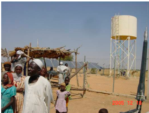
写真-27 Alifa 町の太陽光揚水給水施設 2003年にBADEA(アフリカ経済開発アラブ銀行)資金により建設されたソラ-システムレベルIIの給水施設。
