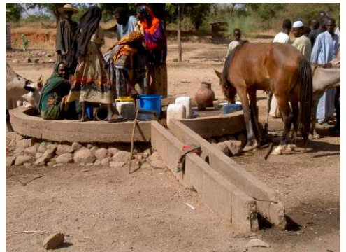
写真-14 Golongti 村のハンドポンプ深井戸 排水用のピット (浸透枡) が無い。井戸に囲いが無く家畜がアクセスできる。
