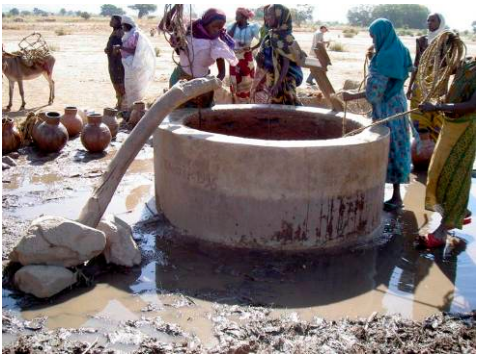
写真-11 Zony 村の浅井戸 人口約 500 人。FIDA-GTP により 1996 年に設置されたコンクリート保護の浅井戸。水位 13.70m。やや濁っている。水量は年中あり。井戸の周囲はぬかるんでいる。
