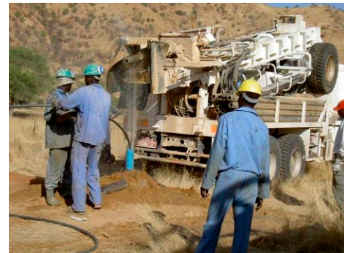
写真-8 Télélé 村の深井戸掘削現場 井戸洗浄中。岩盤（シスト）中に深度 56m まで掘削し、7500/hr の水量を得た。
