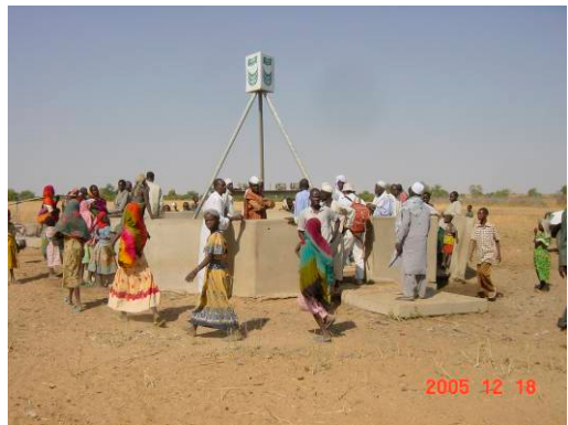
写真-28 Douldjaya II 村の浅井戸 1989年にサウジアラビア開発基金の資金で建設したコンクリートリング大口径浅井戸。飲料水と家畜用の共用。
