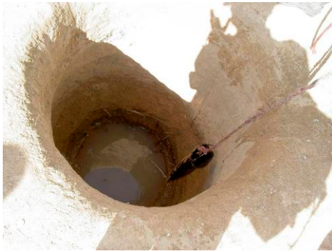
写真-5 Atim 村の伝統的浅井戸 ワジ沿いの砂層中に掘った素掘りの伝統的浅井戸。シルトにより水は非常に濁っている。水位は 2.30m と浅い。乾期には涸れる。
