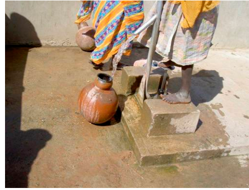
写真-2 バルニエ足踏み式ポンプ 人口 550 人の Ouidiguine 村には、写真 1 のものと合わせて、バルニエ製足踏み式ポンプが 2 箇所設置された。
