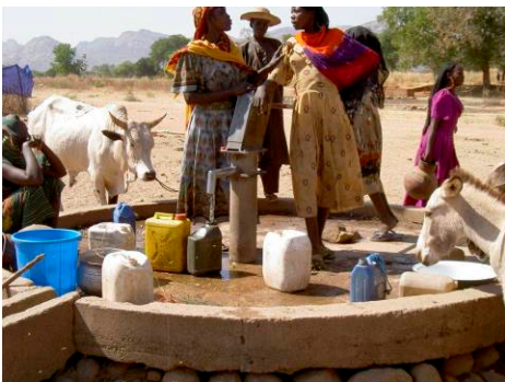
写真-13 Golongti 村のハンドポンプ深井戸 人口約 1000 人。深井戸にインディア Mk II 型のハンドポンプを設置。1992 年に UNDP が建設した。10 年以上経過しているが良く稼働している。
