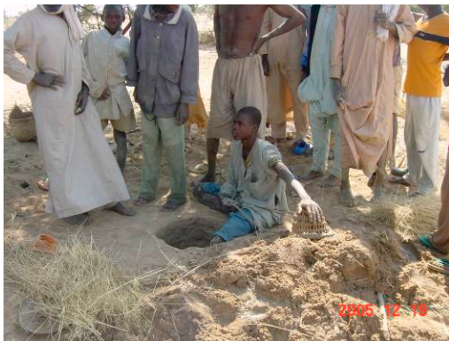
写真-31 Abou Gara 村の掘削中のピット 村の飲料水水源として手掘りピットを掘削中。地下水位は 4m。この地域のピット群は 12 月末頃に枯れる。
