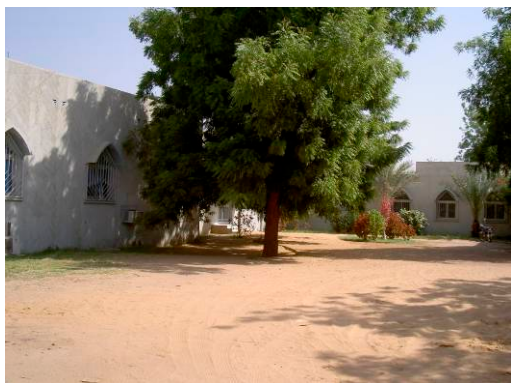
写真-33 水利局本部 ンジャメナの水利局本部が占有する建物。
