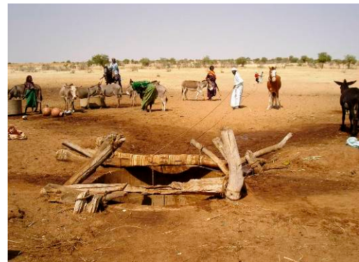
写真-30 Bachama 村の大口径手掘り井戸 深さ 65m もの大口径手掘り井戸、動物の糞便が直接入る構造で極めて不衛生。村の人口約 1000 人で周辺 9 村も利用している。
