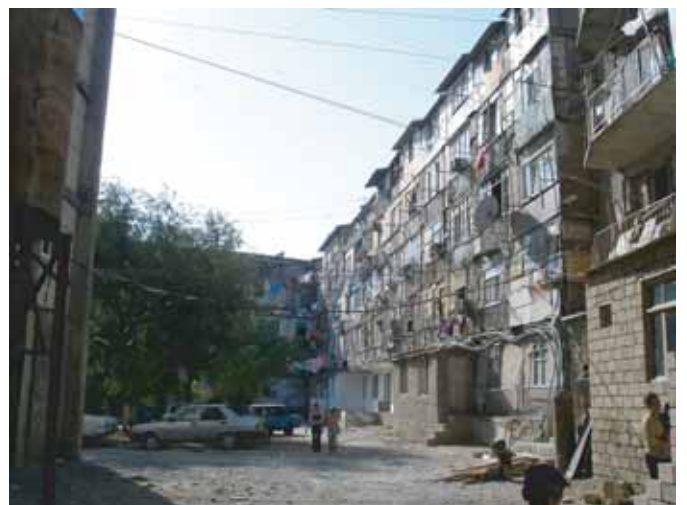
国内避難民の居住棟（ヤサマル地区） (ムシュビク変電所の供給エリア)
