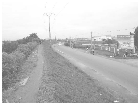
環状線として国道7号線を越えて接続することになる58-A号線の状況。堤防の天場は歩道で、国道は小段を走る。
