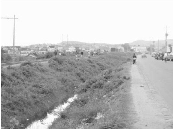
代替案3の計画道路予定地の線路、水路及び市道。この水路を埋めれば、道路用地が造成される。
