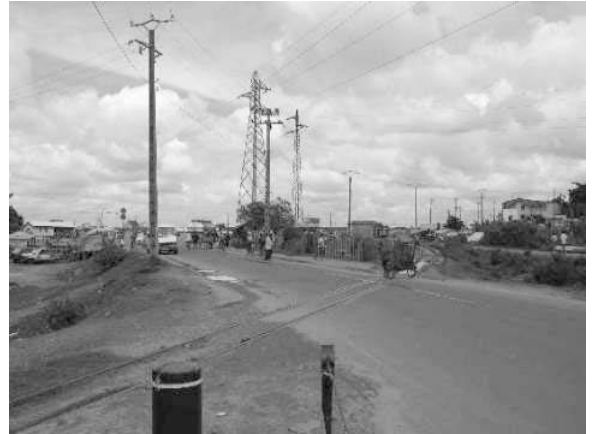
国道 7 号線と道路 3 系統が交差する地点には、鉄道 2 系統、水路 3 系統、高圧線を含む鉄塔・電線などインフラが高密度に集積。
