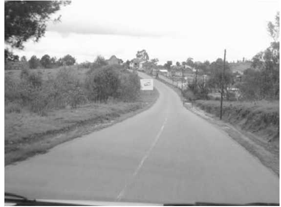
国道7号線の滑らかな線形が続く郊外区間。車道の舗装幅員は約6m。
