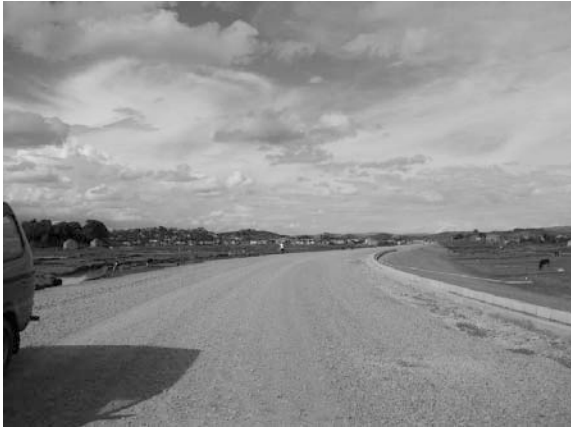
施工中のバイパスの計画道路接続点付近。半径240mの曲線区間。
