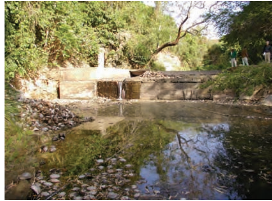
取水堰全景（下流側から）
