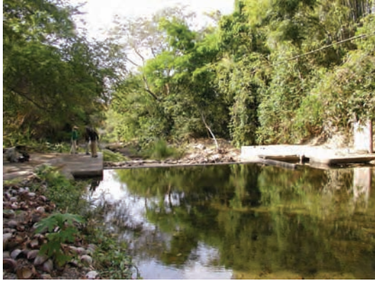
取水堰全景（上流側から）
