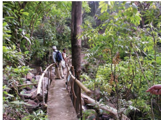
貯水ダムまでの林道（送水管敷設予定地）
