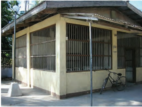
Maliig バランガイホール外観
