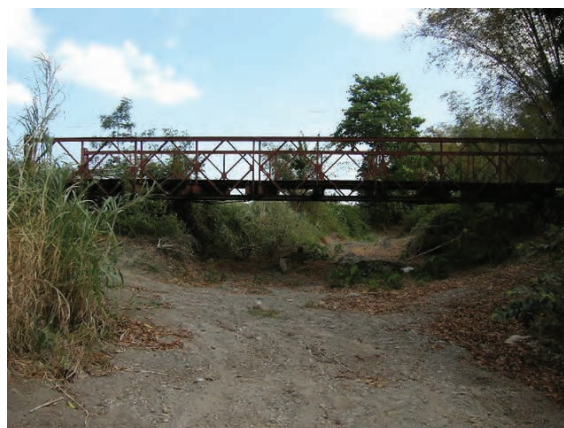
国道に架かる橋梁 (1 区間)
