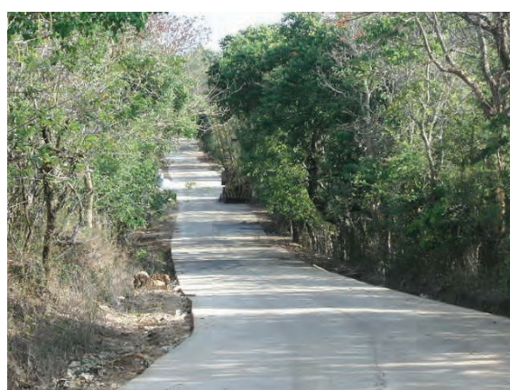
国道コンクリート舗装 (E 区間)
