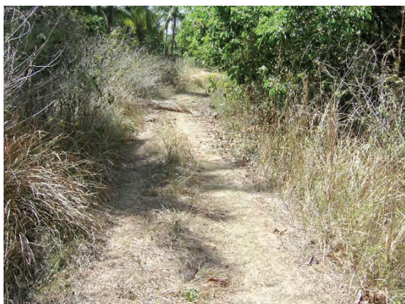
バランガイ道路現況 (N 区間)
