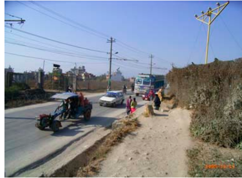
写真 (2) 空港照明灯が道路境界に近接している地点。
