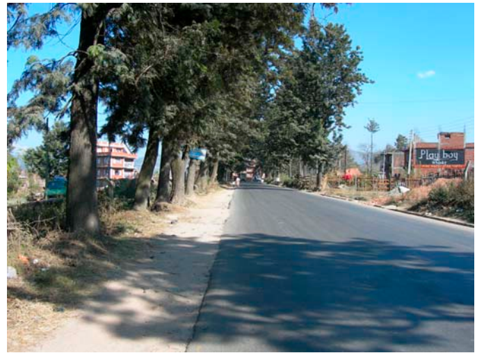
スルヤビナヤク交差点を過ぎるとスイスの援助による堅牢な舗装面となっている。
