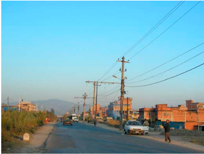
トロリーバスの架線は取り外されているが、電柱には電力線、電話線などが添接されている。
