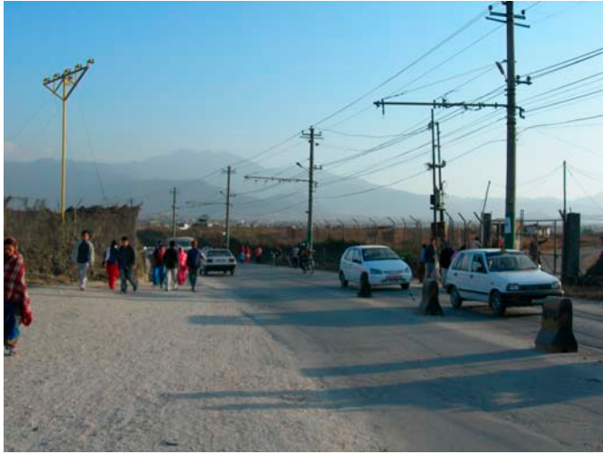
左側に見える滑走路用誘導灯が道路付近に建てられている。今後の ROW 確保の調整が必要である。
