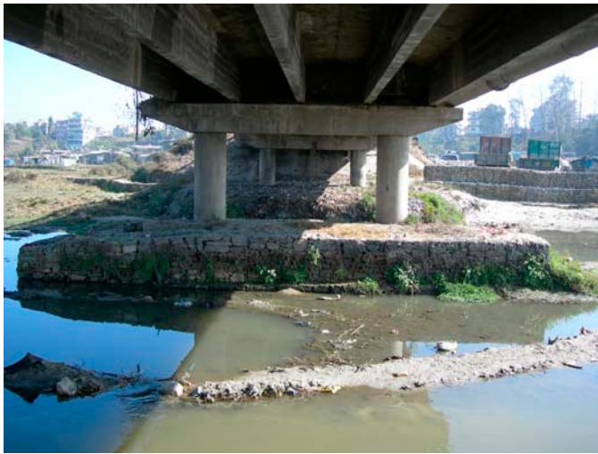
マノハラ橋の橋脚はギャビオン（布団かご）によって洗掘防止工が施されている。
