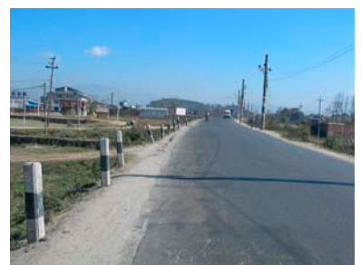
ハヌマティ橋の手前付近で、盛土区間のため、車両転落防護柵が見られる。
