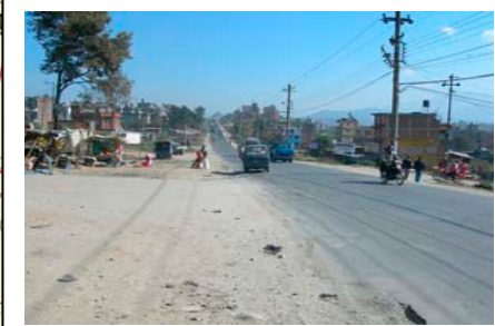
サグの区間で、勾配は4%前後と思われる。遠方はすでに上り勾配が見える。
