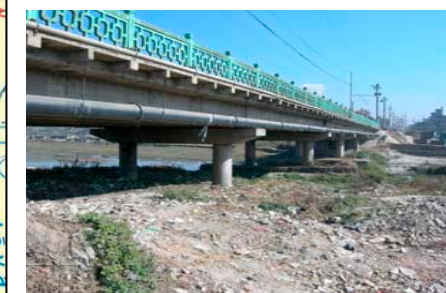
マノハラ橋を下流側から望む。橋脚は布団かごで補強されている
