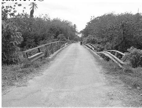
高覧が両側に押し広げられ外側に折れ曲がり破損している。
