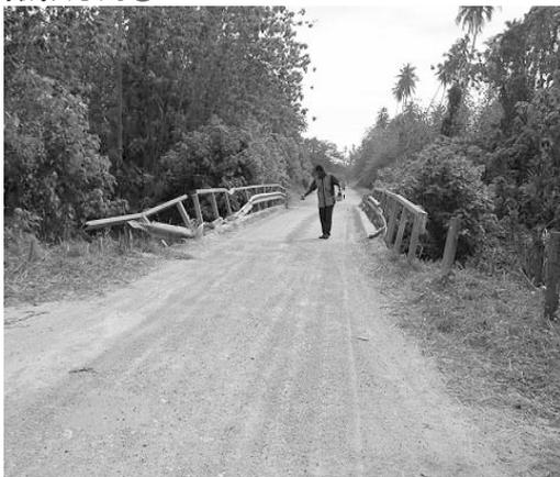
高覧が両側に押し広げられ外側に折れ曲がり破損している。
