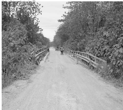
舗装は両岸とも破壊している。
